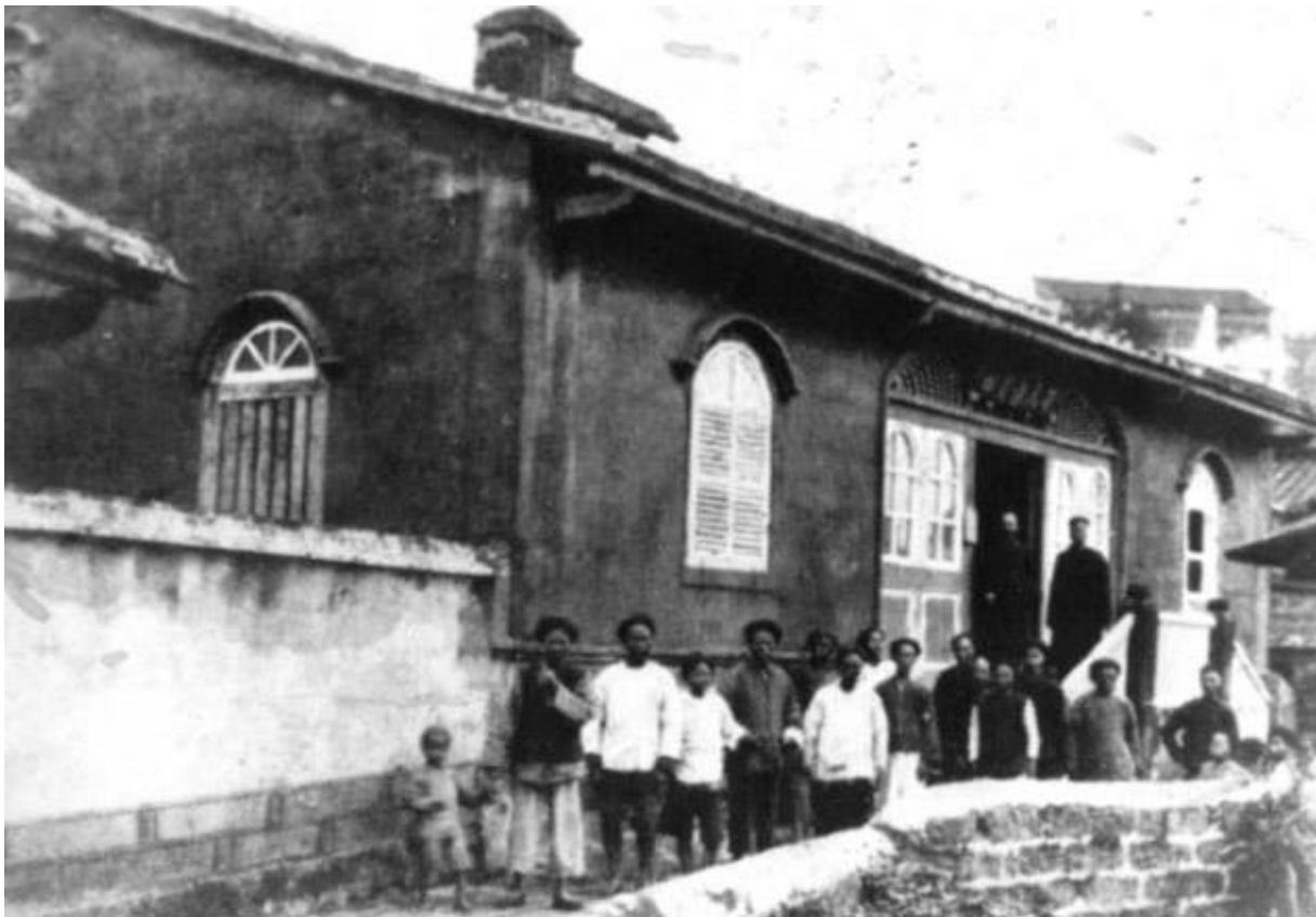
1880年「偕醫館」(舊貌)
